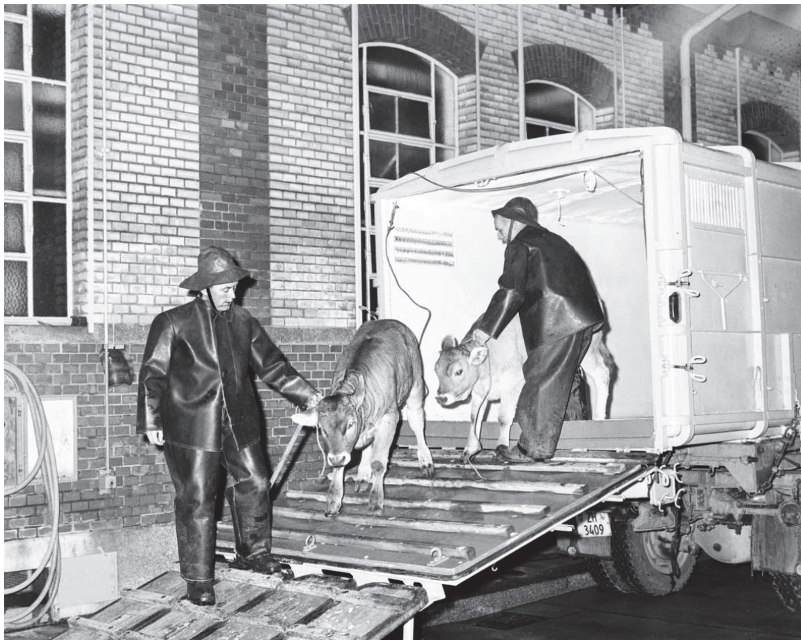
Der letzte Gang: Zwei Kälber werden 1965 in den alten Zürcher Schlachthof geführt.
